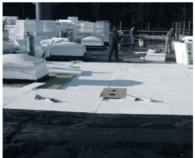
Verlegbeispiel EPS Gefälle-Dämmplatten
