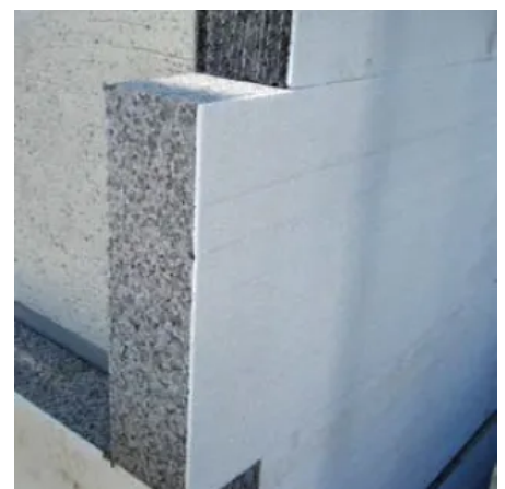
Verlegebeispiel duopor® Fassadendämmplatten
