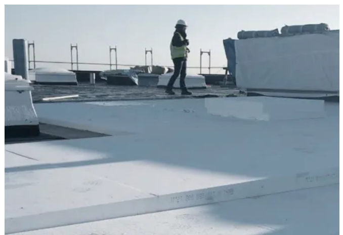
Verlegebeispiel EPS Flachdach-Dämmplatten
