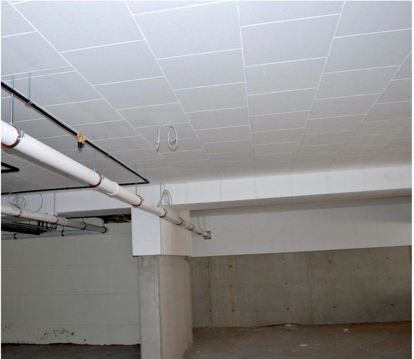
Tiefgaragendecke gedämmt mit Hirsch Porzell Deko-Dämmplatte 035 DI
