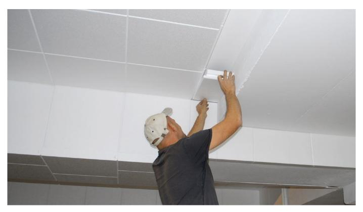
HIRSCH Porozell Dämmlösungen für den Keller im Innenbereich: Deko-Dämmplatten mit Strukturprägung und gefasten Kanten für hochwertige Deckenansichten oder Kellerdecken-Dämmplatten ohne Strukturprägung als wirtschaftliche Lösung der nachträglichen Kellerdeckendämmung.
