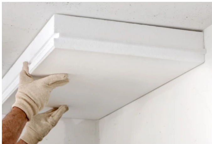
Die Kellerdecken-Dämmplatten lässt sich durch Nut-Feder- oder Stufenfalzverbindung wärmebrückenfrei verlegen.
