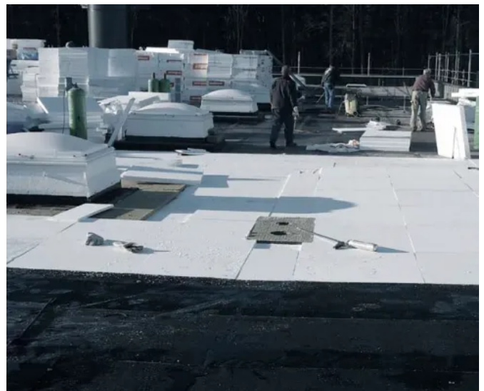
Verlegbeispiel EPS Gefälle-Dämmplatten
