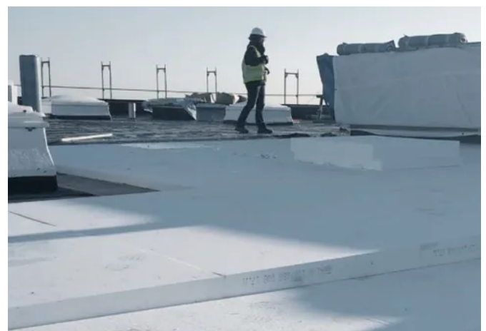
Verlegebeispiel EPS Flachdach-Dämmplatten
