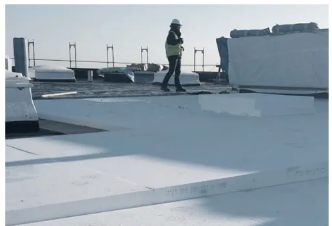
Verlegebeispiel EPS Flachdach-Dämmplatten
