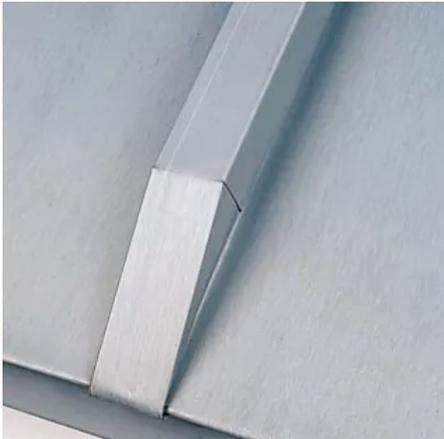
Das Leistensystem ist das traditionellste System der heute üblichen Klempnertechniken. Der Name „Leistenfalz“ steht für eine Art der Längsverbindung, bei der zwischen den Scharen als Befestigung der RHEINZINK-Klick-Leistenhalter aus verzinktem Stahl verlegt wird. Beide Befestigungsalternativen werden mit einer Leistenkappe abgedeckt. Das System überzeugt durch eine effiziente Verlegung. Vorgefertigte Anschlussprofile unterstützen die Ausführungsqualität und eine anspruchsvolle Optik.
