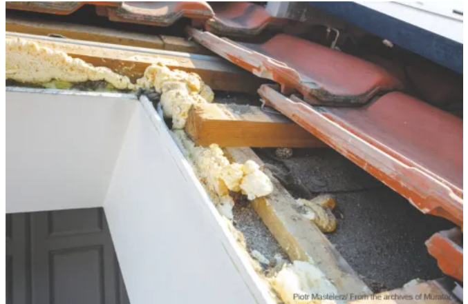
Freigelegte Fensteröffnung mit unbeschädigter Fensternische
