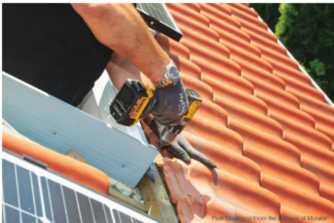
Blendrahmenmontage auf dem bestehenden Innenfutter
