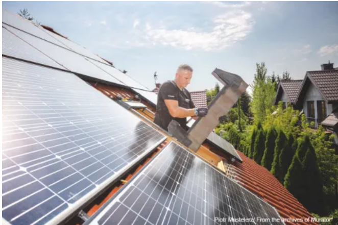
Demontage des alten Dachfensters nebst Eindeckrahmen außen
