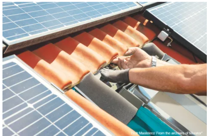
Winddichter, wärmedämmender Dachanschluss mit Eindeckrahmen
