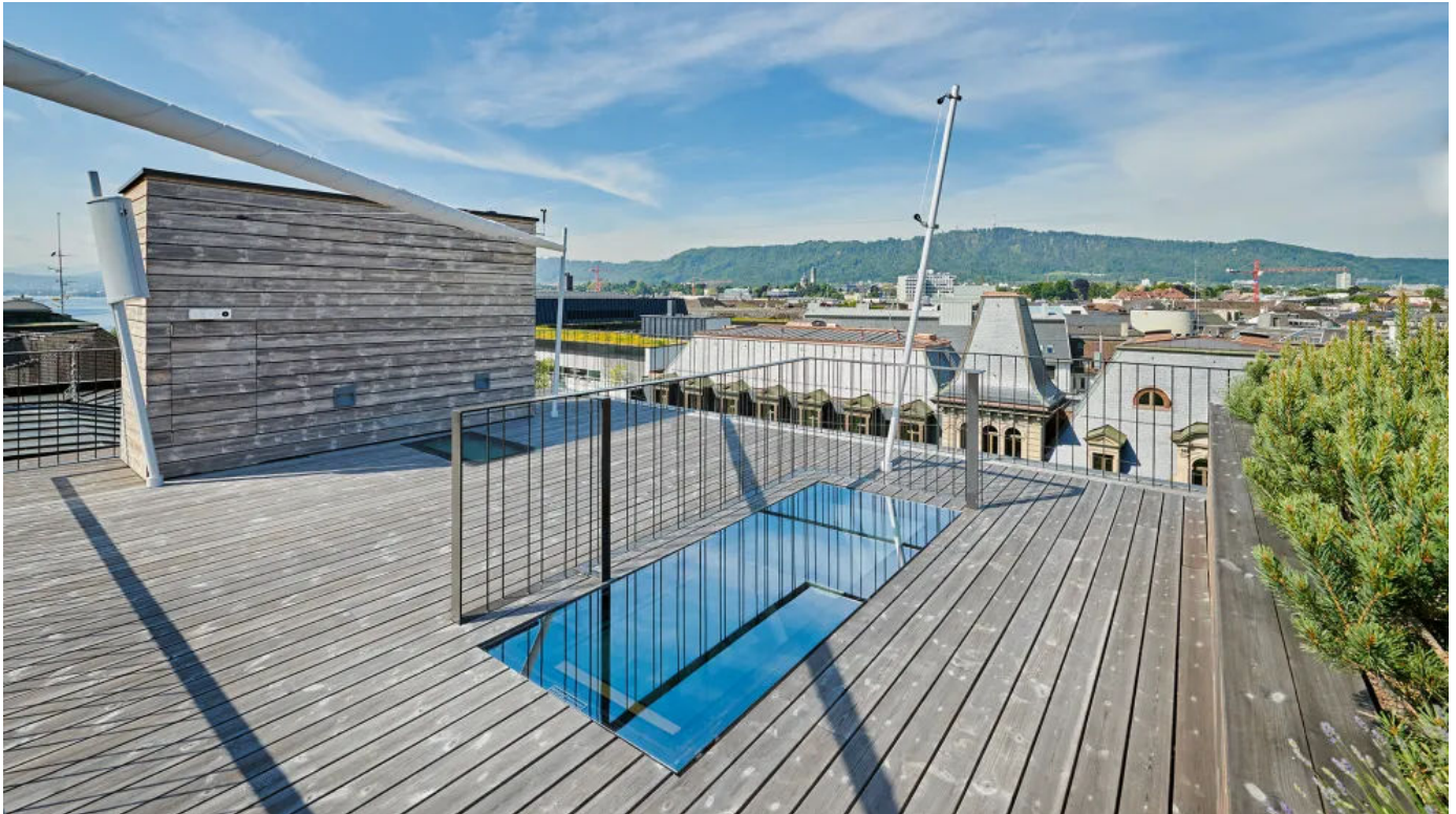
Dachausstieg s: 211 E DA
