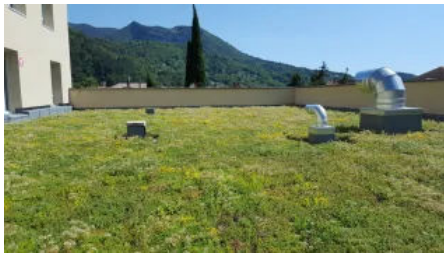
Krankenhaus, Nyon (Schweiz), 210 m2 Dachbegrünung
