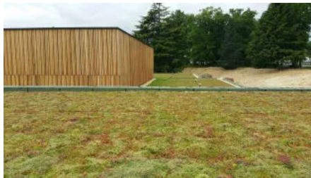
Krankenhaus, Embrun (Frankreich), 570 m2 Dachbegrünung
