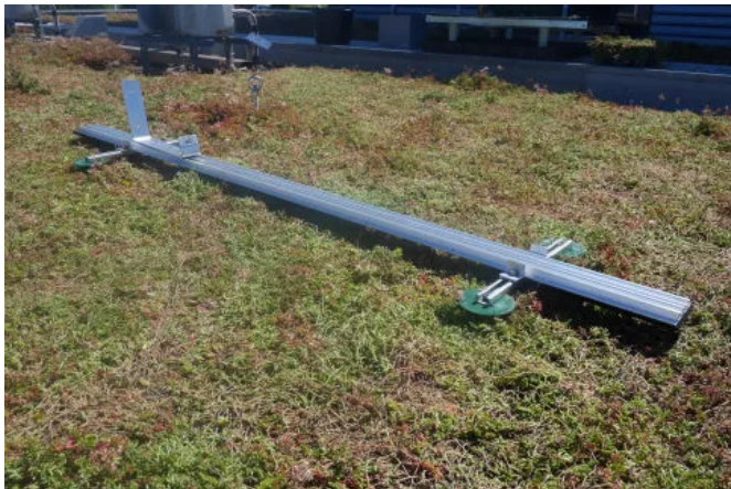
Befestigungsschiene verankert im Gründach
