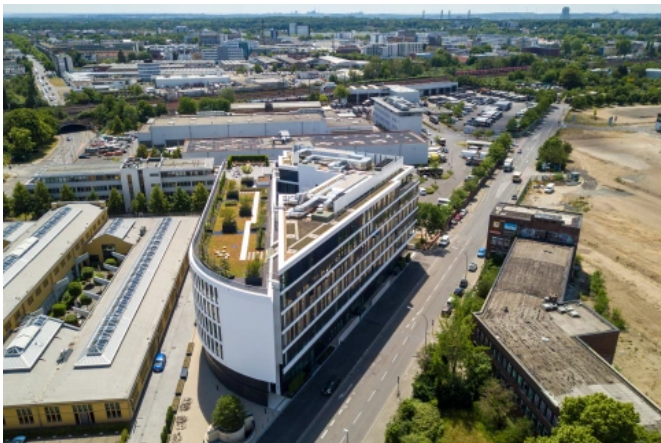
Ein sehenswerter Dachgarten auf einem Bürogebäude - The Ship Köln – © Optigrün
