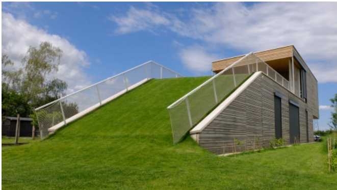
Schrägdachfläche in ein Privathaus integriert - Götzendorf – © Optigrün
