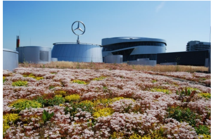
Mercedes Benz Fabrikgebäude - Stuttgart
