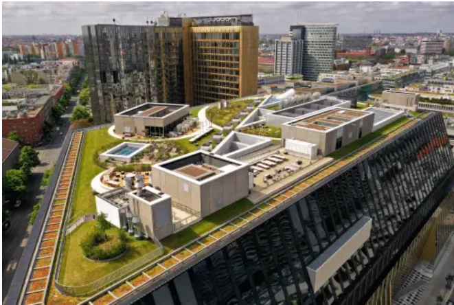
Eine ausgeprägter Dachgarten auf dem Axel Springer Haus - Berlin – © Optigrün
