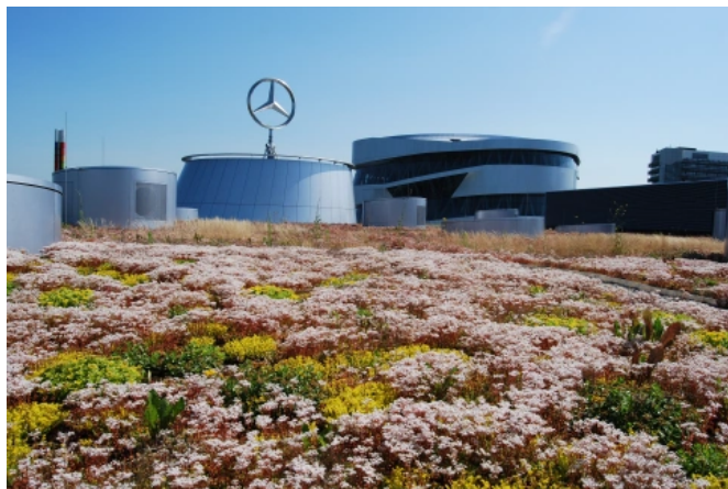
Mercedes Benz Fabrikgebäude - Stuttgart
