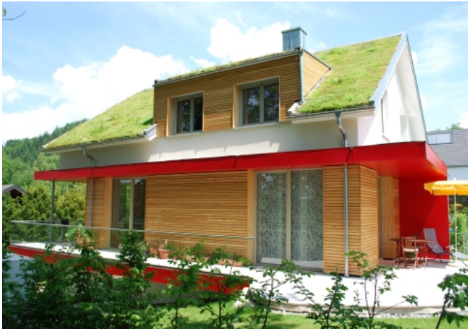
Privathaus - Freiburg – Schrägdach Typ Netz und Schwelle – © Optigrün
