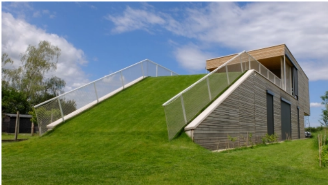
Schrägdachfläche in ein Privathaus integriert - Götzendorf – © Optigrün
