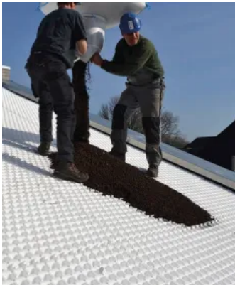
Schrägdach 15–35° mit Schubsicherung P – © Optigrün
