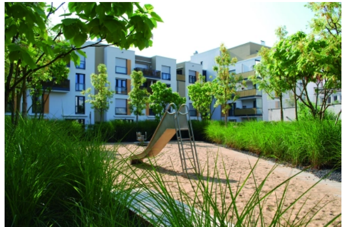
Landschaftsdach mit Spielplatz auf einer Tiefgarage - Köln – © Optigrün
