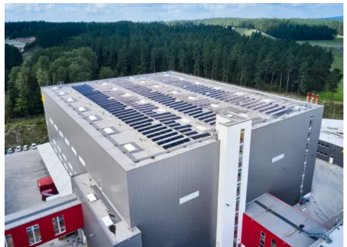
Warenverteilzentrum Witt, Weiden | Verwendetes Produkt: Rhenofol CV
