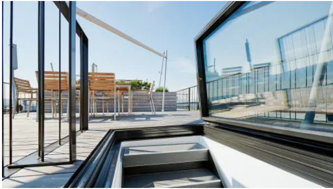
Dachausstieg s: 211 E DA
