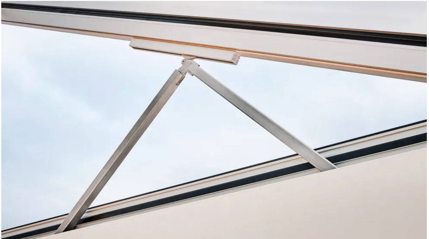
Sichtbare Antriebsteile RA
