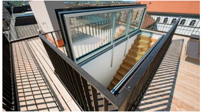
Dachausstieg s: 211 E DA
