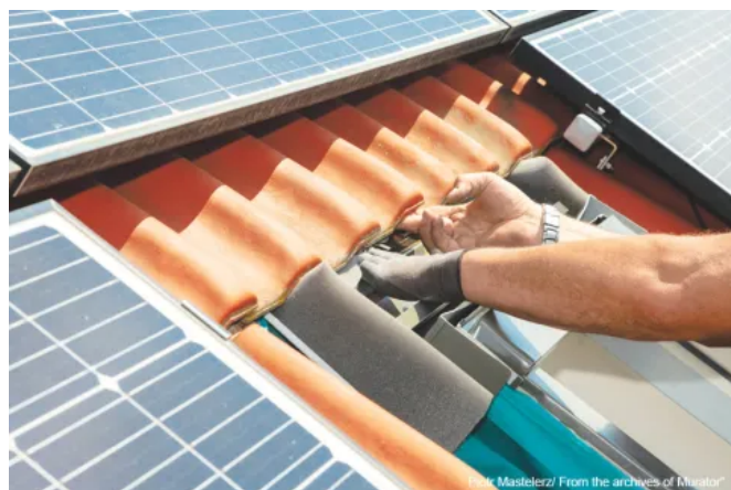
Winddichte, wärmedämmender Dachanschluss mit Eindeckrahmen
