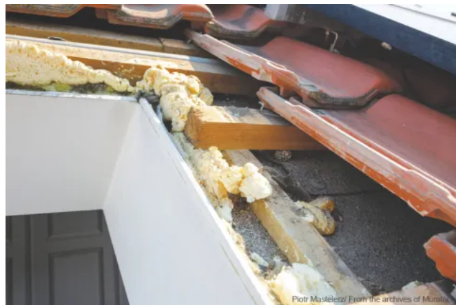
Freigelegte Fensteröffnung mit unbeschädigter Fensternische
