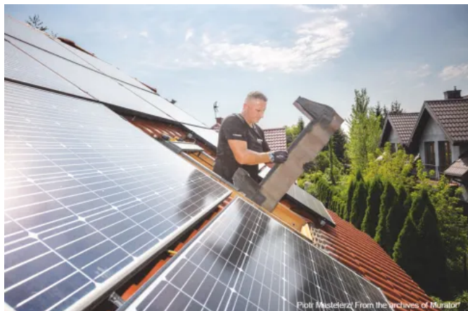
Demontage des alten Dachfensters nebst Eindeckrahmen außen
