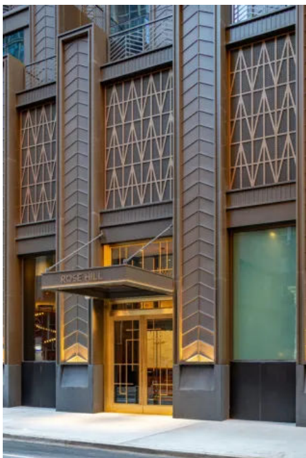
Wetterschutzgitter im Rose Hill Wohngebäude (© Lester Ali)
