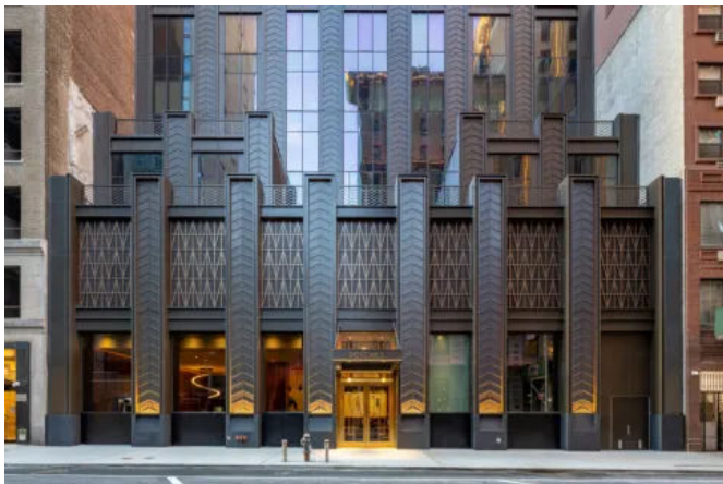
Wetterschutzgitter im Sockelbereich des Rose Hill Wohngebäude in New York (© Lester Ali)
