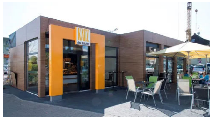
Backshops und Verkaufsräume in Modulbauweise
