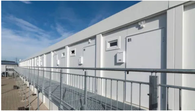
4 Containeranlagen - Erweiterung bestehender Asylunterkunft
