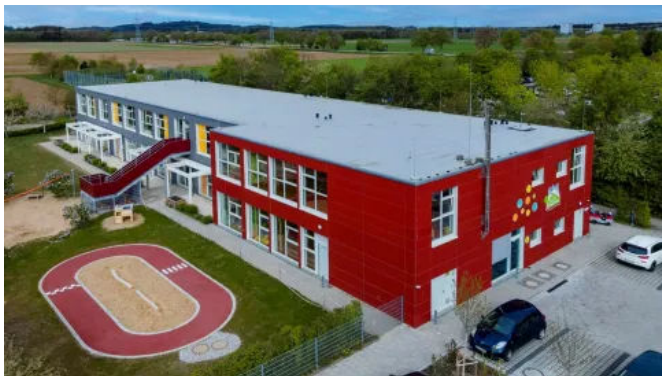
Aufstockung Modulbau - Erweiterung des Kinderhauses Römerauterrasse
