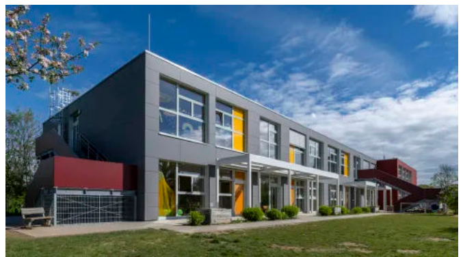
Aufstockung Modulbau - Erweiterung des Kinderhauses Römerauterrasse
