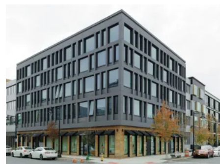
concrete skin Fassadenplatten am Harrison Commons, New Jersey, USA (© Ditz Fejer)
