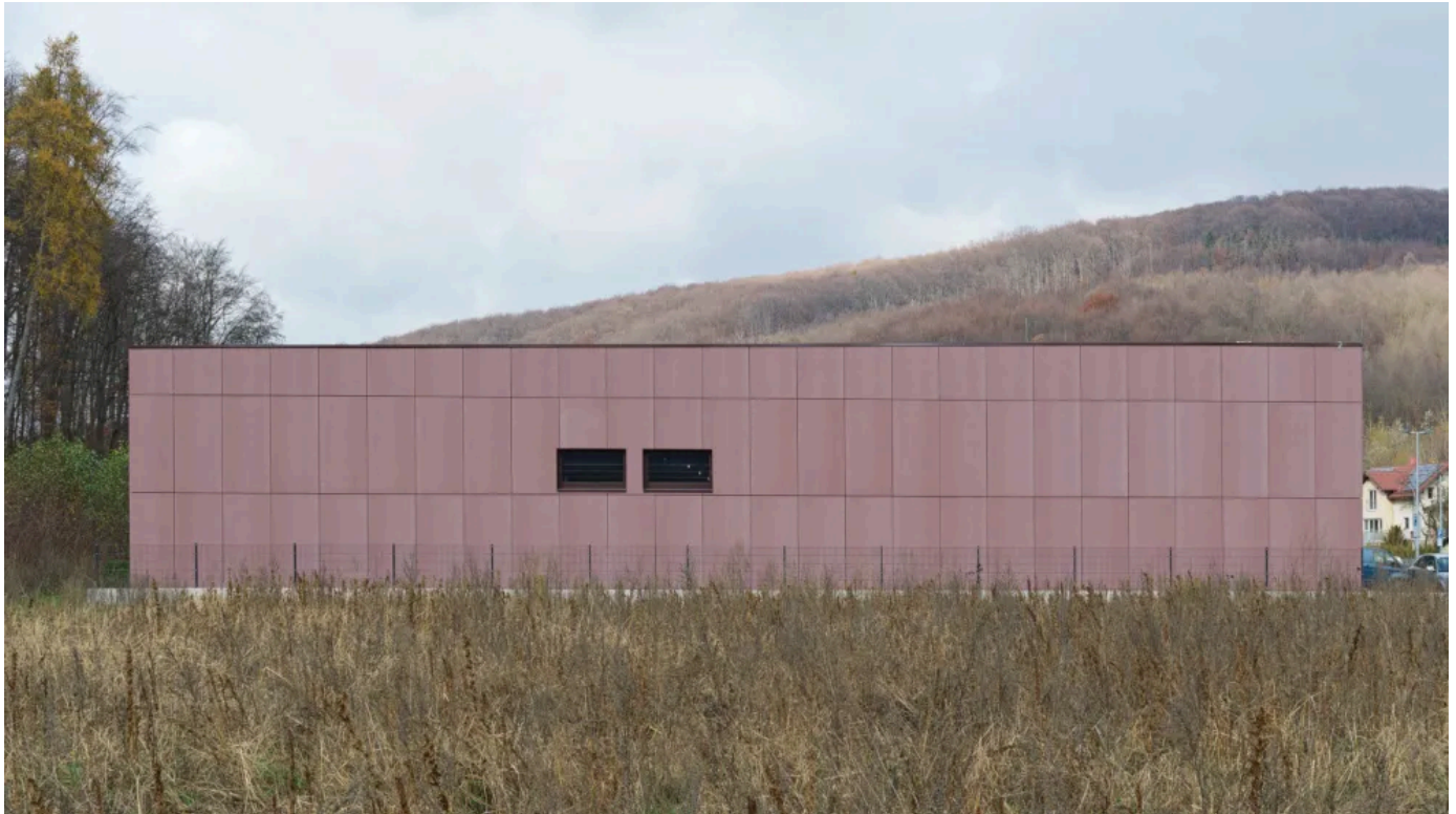
concrete skin Fassadenplatten am Eurospar Mauerbach
