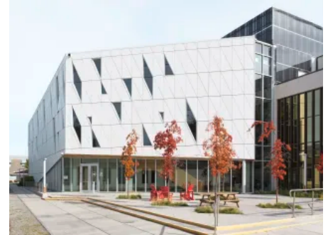
concrete skin Fassadenplatten am Okanagan College, British Columbia, Kanada (© Ditz Fejer)
