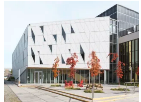
concrete skin Fassadenplatten am Okanagan College, British Columbia, Kanada (© Ditz Fejer)
