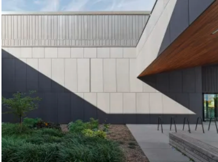
concrete skin Fassadenplatten am Audley Recreation Centre, Kanada (© Ditz Fejer)
