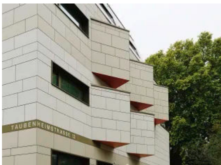
concrete skin Fassadenplatten an Olgakrippe, Stuttgart
