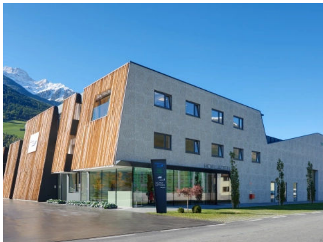
Bürogebäude Herbert Lechner AG, Italien
