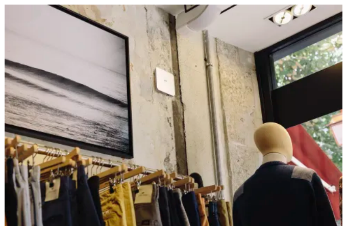
Der IQ ist das Herz von Salto KS. Seine Reichweite kann bei Bedarf mit Repeatern erweitert werden.
