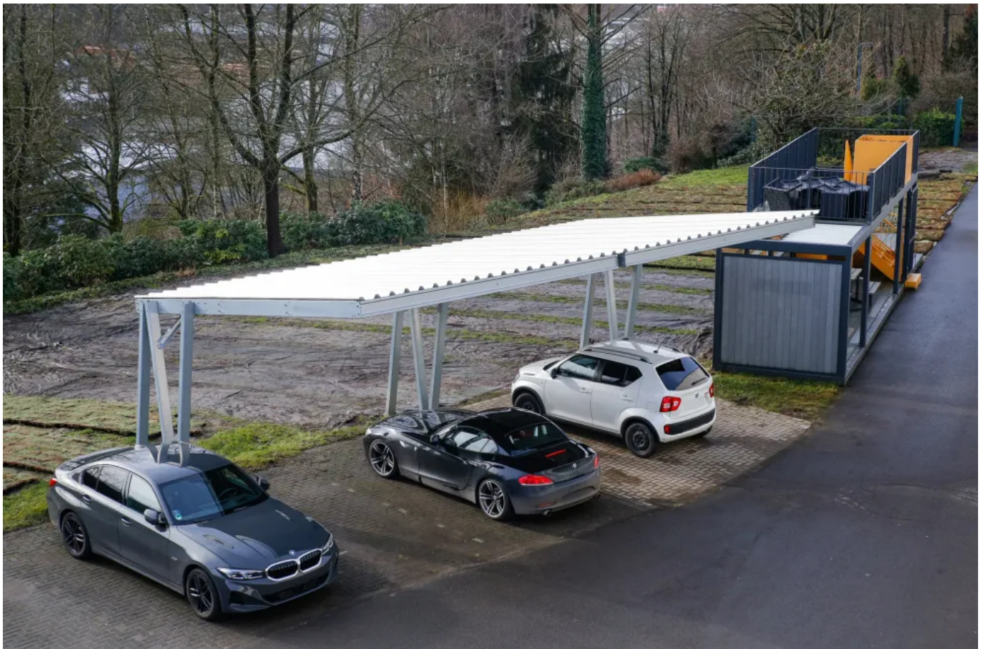
Referenzbeispiel einer EcoCover Carportanlage
