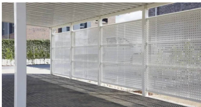
Lochblech nach RAL pulverbeschichtet in weißaluminium matt
