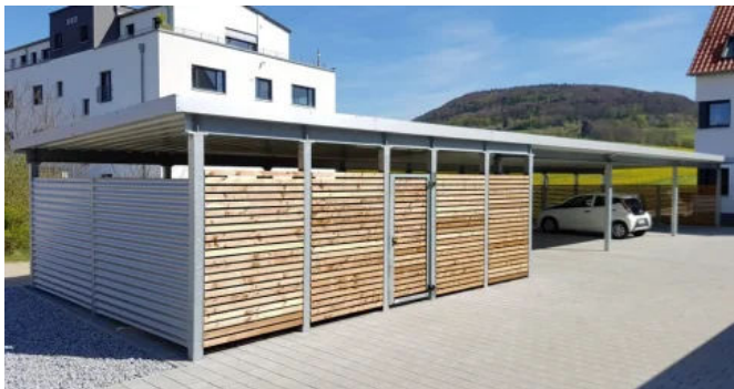
Carportanlage mit Fahrradeinhausung
