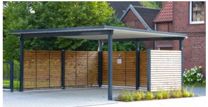
Carport-aus-Stahl-Trapezblech-Dacheindeckung
