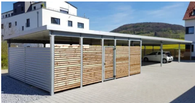
Carportanlage mit Fahrradeinhausung
