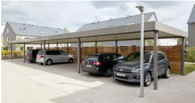
Trapezblechdach und Attika mit Gefälleausgleich
