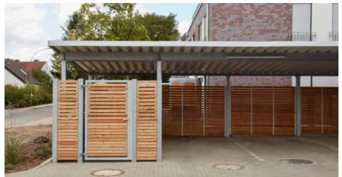
Carport mit abschließbarem Abstellraum
