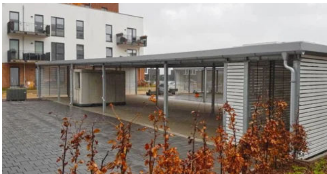
Carportanlage mit Abstellraum
