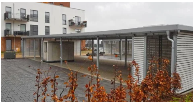
Carportanlage mit Abstellraum
