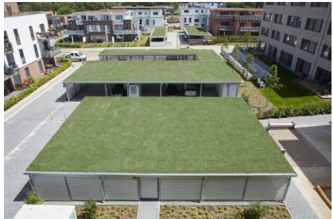
Carportanlage mit Gründach
