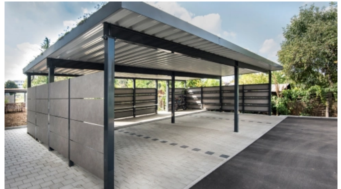
Carportanlage - Gründach light, Seitenverkleidung Trespa® NATURALS Weathered Basalt Matt
