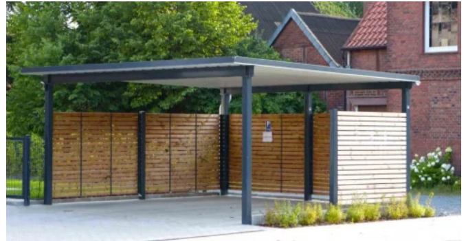
Carport-aus-Stahl-Trapezblech-Dacheindeckung
