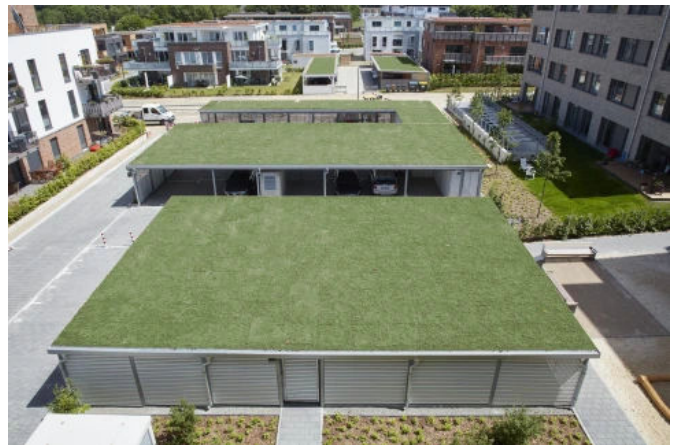
Carportanlage mit Gründach
