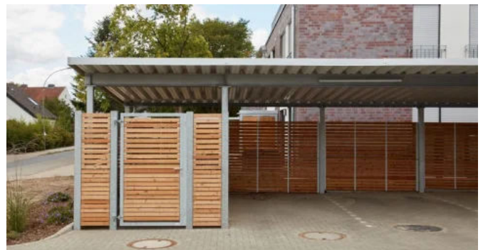
Carport mit abschließbarem Abstellraum
