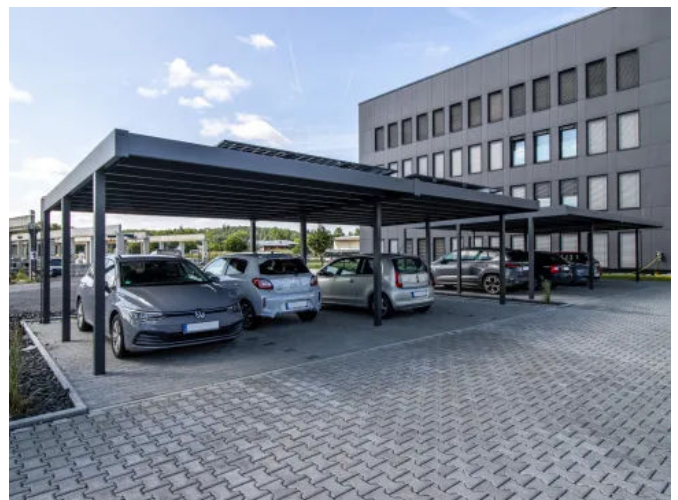
Auf dem Flachdach montierte Solarmodule können über eine Wallbox zur Ladung von Elektroautos genutzt werden.
