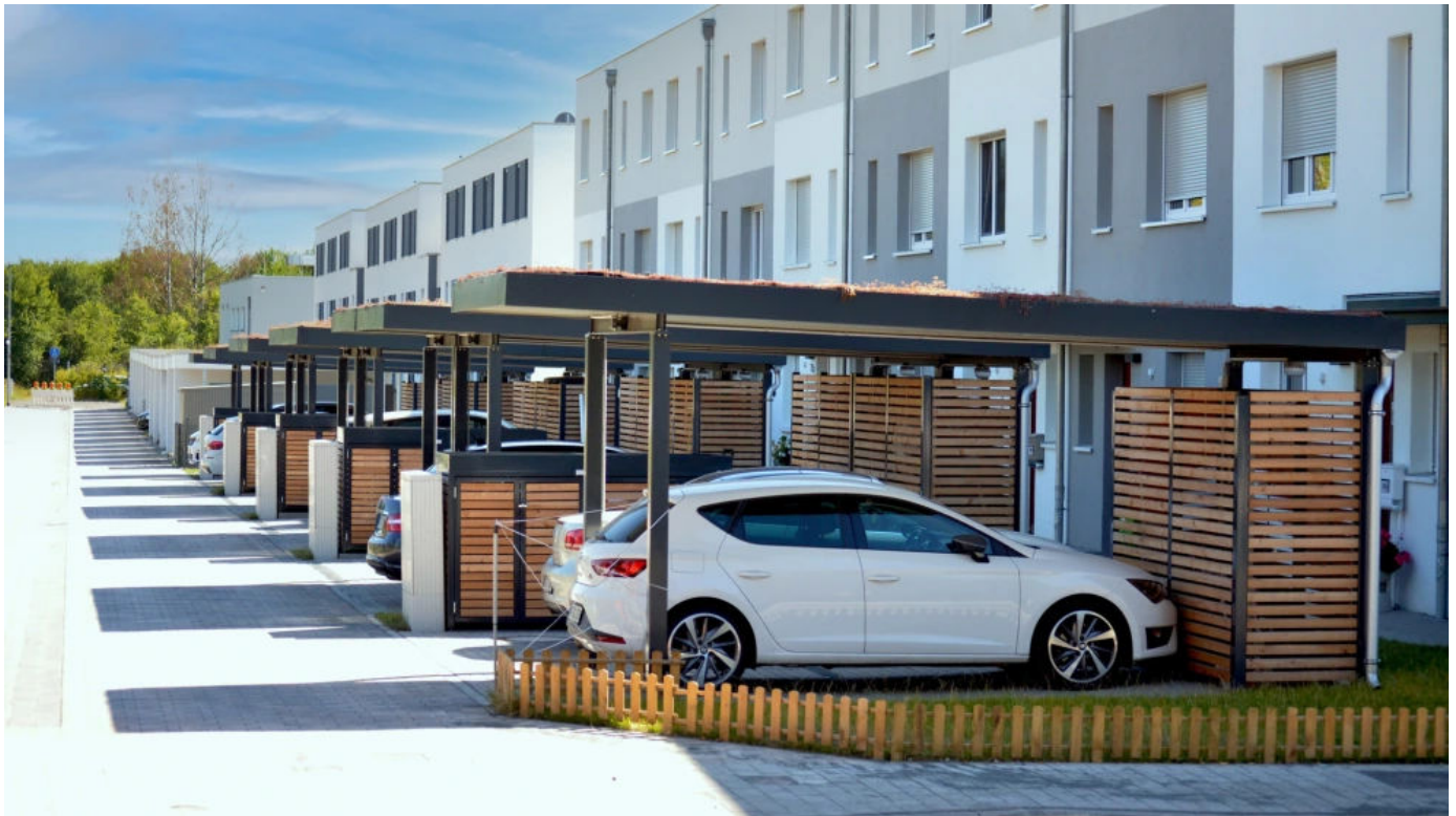
Einzelcarports mit abschließbarem Abstellraum für Reihenhäuser
