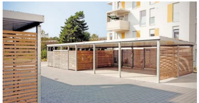
Carportanlage mit Müll- bzw. Fahrradeinhausung
