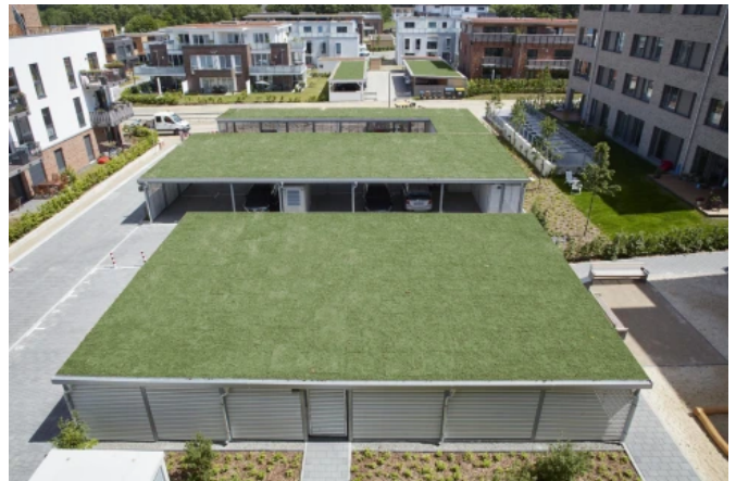
Carportanlage mit Gründach
