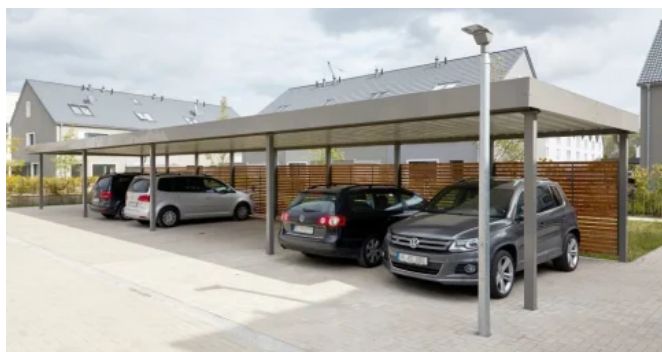
Trapezblechdach und Attika mit Gefälleausgleich
