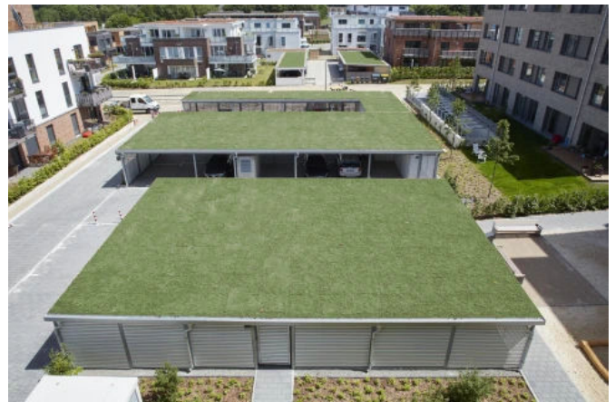
Carportanlage mit Gründach
