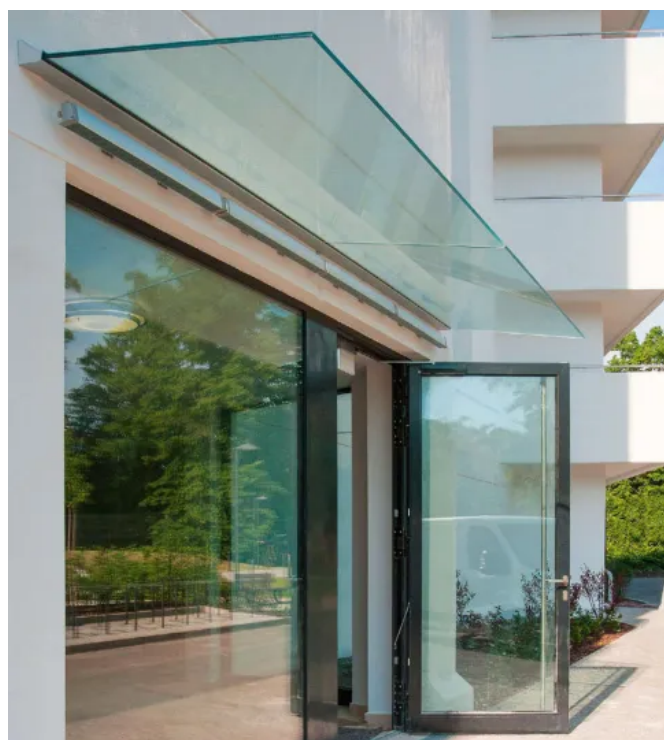
CANOPY cloud Lösung mit durchgehendem Profil und zwei aneinander gereimte Scheiben
