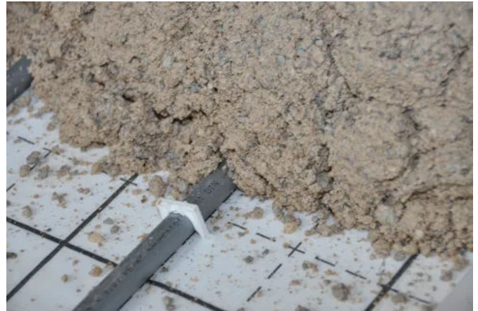
Konventioneller Calciumsulfatestrich auf Fußbodenheizung
