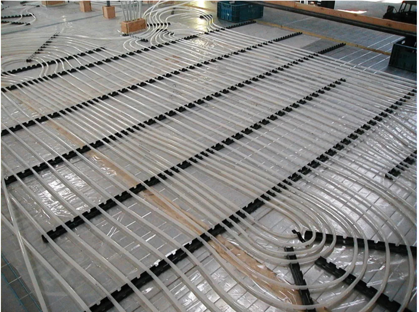
Calciumsulfatestriche auf Basis von LANXESS Anhydritbinder CAB 30 sind als Heizestrich auf Dämmschichten besonders gut geeignet.
