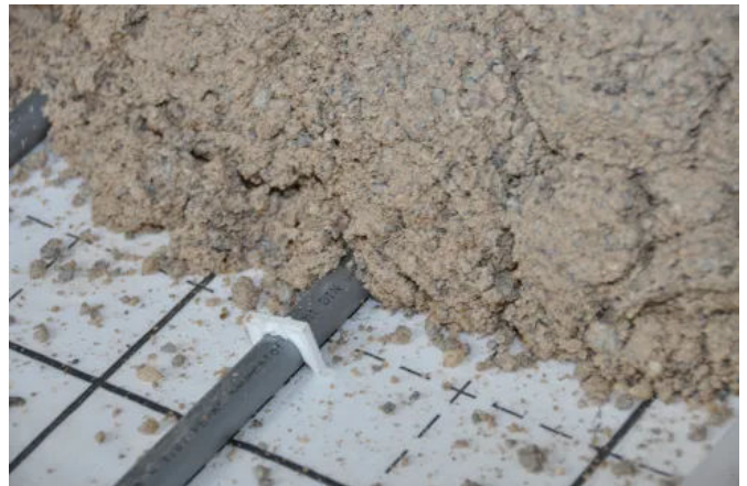
Konventioneller Calciumsulfatestrich auf Fußbodenheizung
