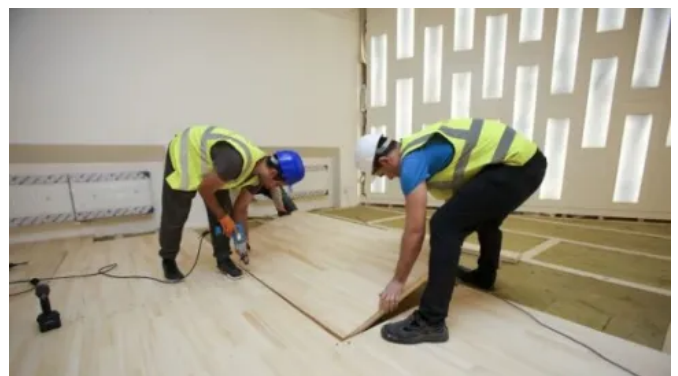
Die verstärkten Verbund-Spanplatten werden auf einer akustischen Trennschicht direkt auf die primäre oder sekundäre Bühnenkonstruktion montiert.
