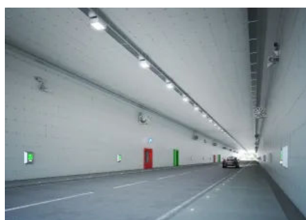
Nachträglich montierte Brandschutzbekleidungen
