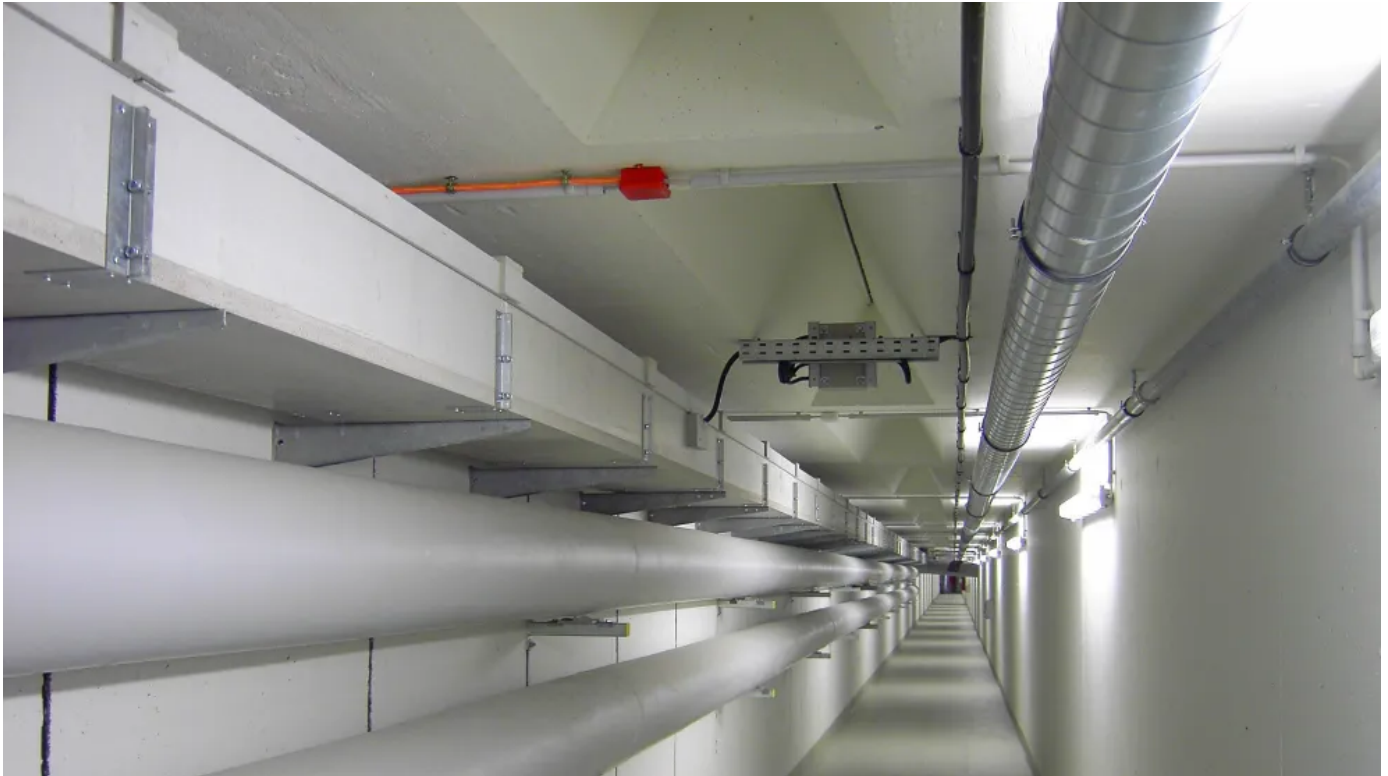
Baulicher Brandschutz für Elektroinstallationen
