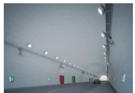
Nachträglich montierte Brandschutzbekleidungen für Tübbingelemente
