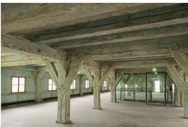
Treppeneinhausung mit Brandschutzverglasung F30/T30
