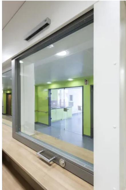
Detail Schiebefenster F30
