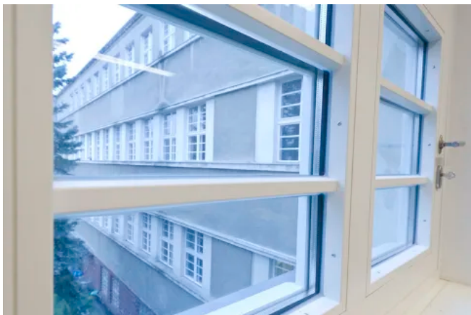
Neue Katholische Hochschule Berlin | Das Gebäude der Neuen Katholischen Hochschule Berlin wurde 1928 von den Marienschwestern aus Breslau als St. Antonius-Krankenhaus errichtet. (© Thomas Moeller)
