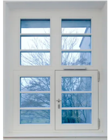
Neue Katholische Hochschule Berlin | Im Rahmen der Sanierung wurden auch moderne Brandschutzmaßnahmen umgesetzt, abgestimmt auf die denkmalgeschützte Bausubstanz. (© Thomas Moeller)
