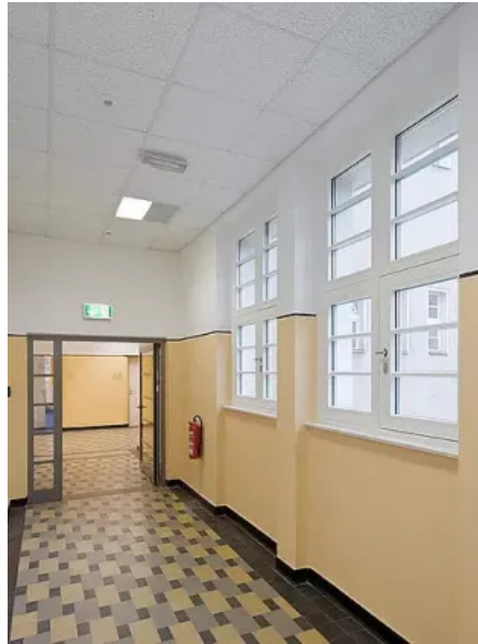
Neue Katholische Hochschule Berlin | Bis heute sind zahlreiche originale Elemente wie Sprossenfenster, Fliesen und Bauplastiken erhalten, was dem Gebäude Denkmalstatus verleiht. (© Thomas Moeller)
