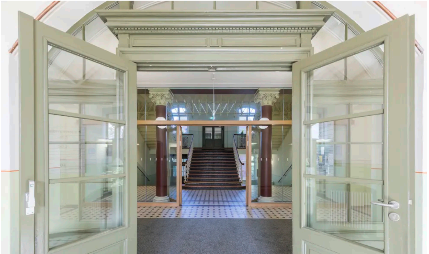
Rote Schule Grimma | Die Montage der schweren Brandschutzverglasung (insgesamt 3.500 kg) erfolgte in fünfeinhalb Wochen ausschließlich während schulfreier Zeiten. (© Thomas Moeller)
