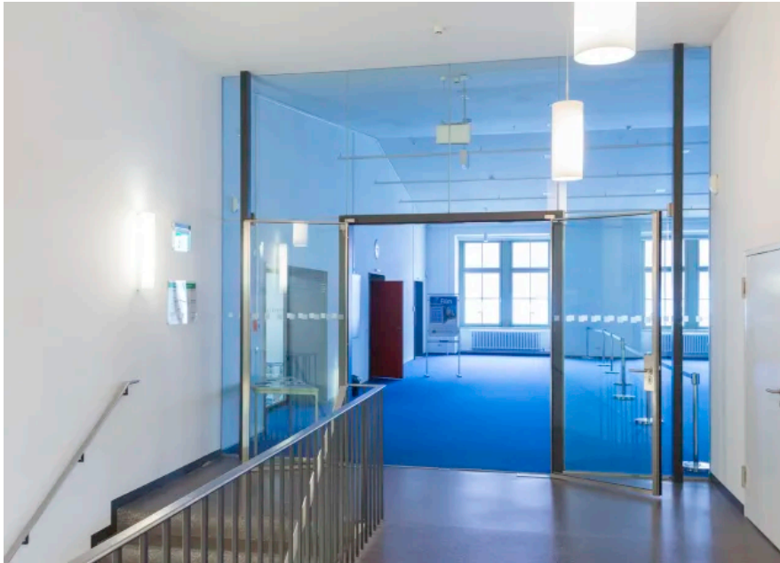
Sächsisches Verkehrsmuseum | Im Zuge der Sanierung wurde auf größtmögliche Transparenz geachtet und moderne Brandschutzverglasungen ohne allgemeine bauaufsichtliche Zulassung integriert. (© Thomas Moeller)
