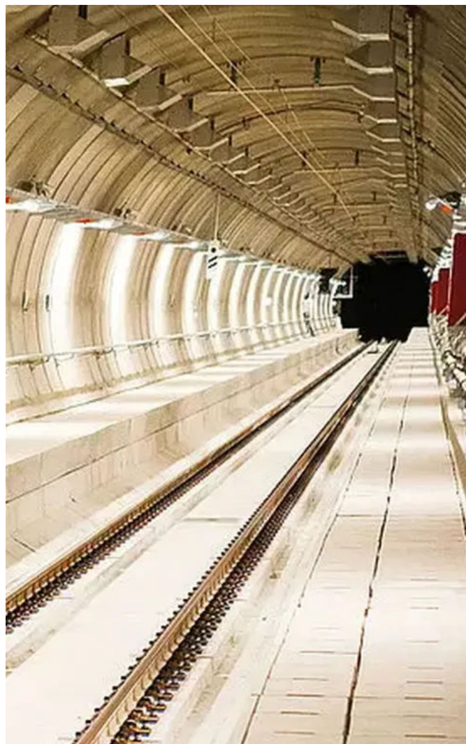
Eisenbahntunnel Liefkenshoek Belgien
