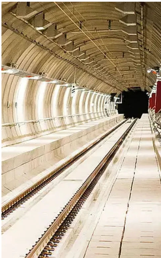
Eisenbahntunnel Liefkenshoek Belgien
