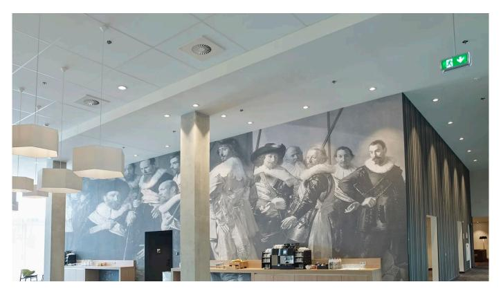
Brandschutzdecken von OWA umfassen feuerhemmende bis feuerbeständige Dach- und Deckenkonstruktionen. In Verbindung mit den nicht brennbaren OWA Deckenplatten der Baustoffklasse A2-s1,d0 sind OWA Brandschutzdecken für Decken aus Beton, Stahlträgern und Holz geprüft und erreichen Feuerwiderstandsklassen bis REI 180 (F 180 nach DIN 4102). Bei OWA sind auch die Unterkonstruktionssysteme Brandschutz geprüft – für Brandschutz aus einer Hand.
