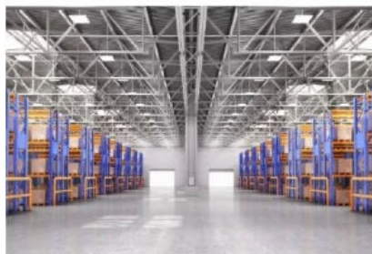
Die TELENOT-Lösung: Brandmeldesystem hifire 4000 BMT.
