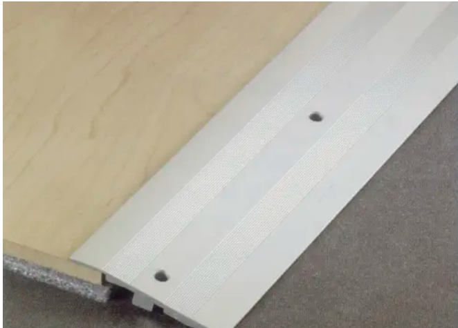
... zugeschnittene Rampe aufsetzen ...
