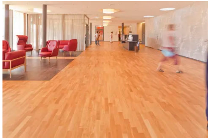
On-Top-beschichteter Boden der Empfangshalle des Altenheims Pfister, Schweiz
