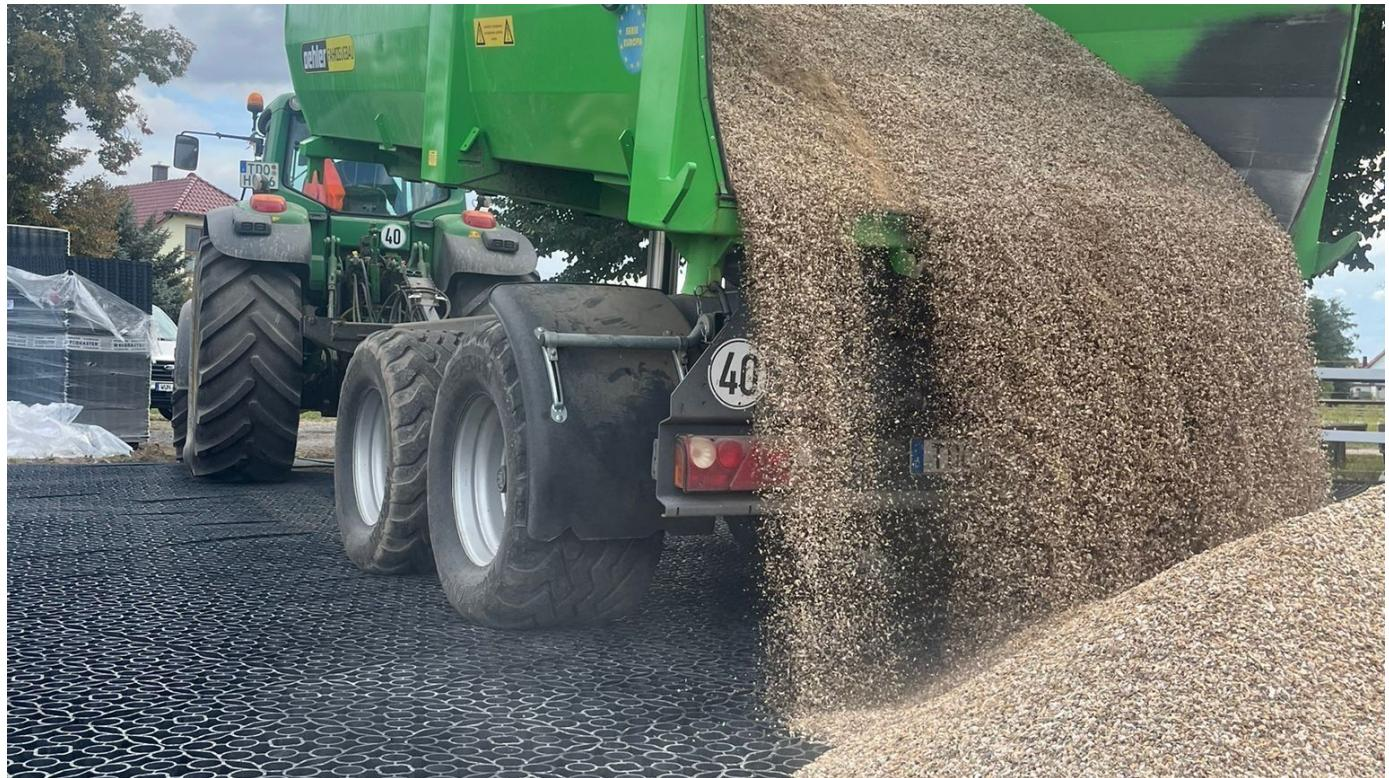
Die versiegelungsfreie Bauweise des Bodengitters ECORASTER® ermöglicht die Versickerung von Regenwasser an Ort und Stelle. Dies führt zu einer Reduktion der Risiken und Konsequenzen von Hochwasser sowie einer gleichzeitigen Bekämpfung von Hitzeinseln, da die gespeicherte Feuchtigkeit durch Verdunstung eine kühlende Wirkung entfaltet.
