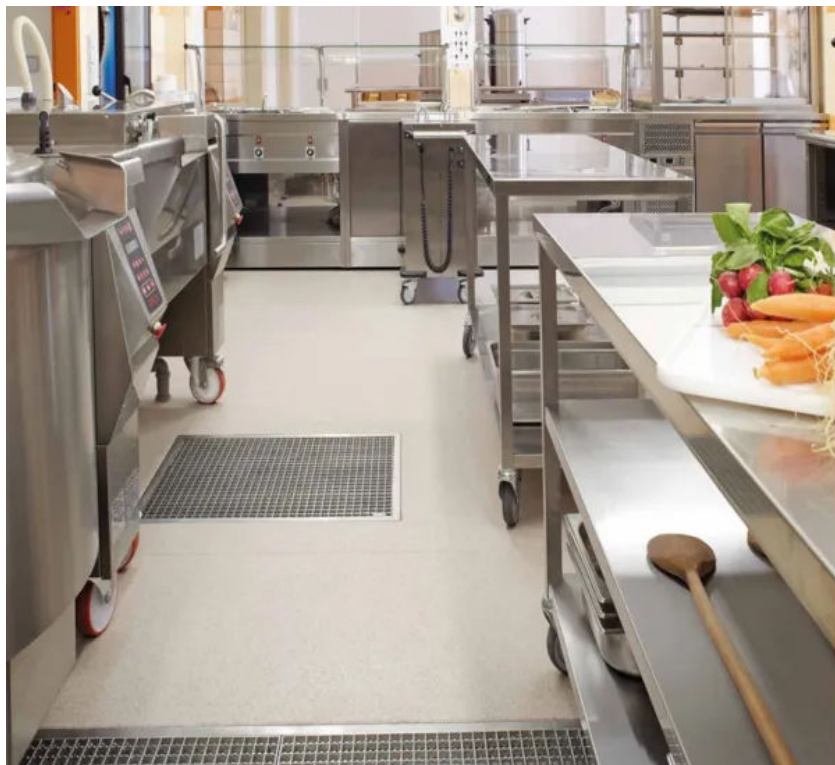
Großküche | © ACO Haustechnik
