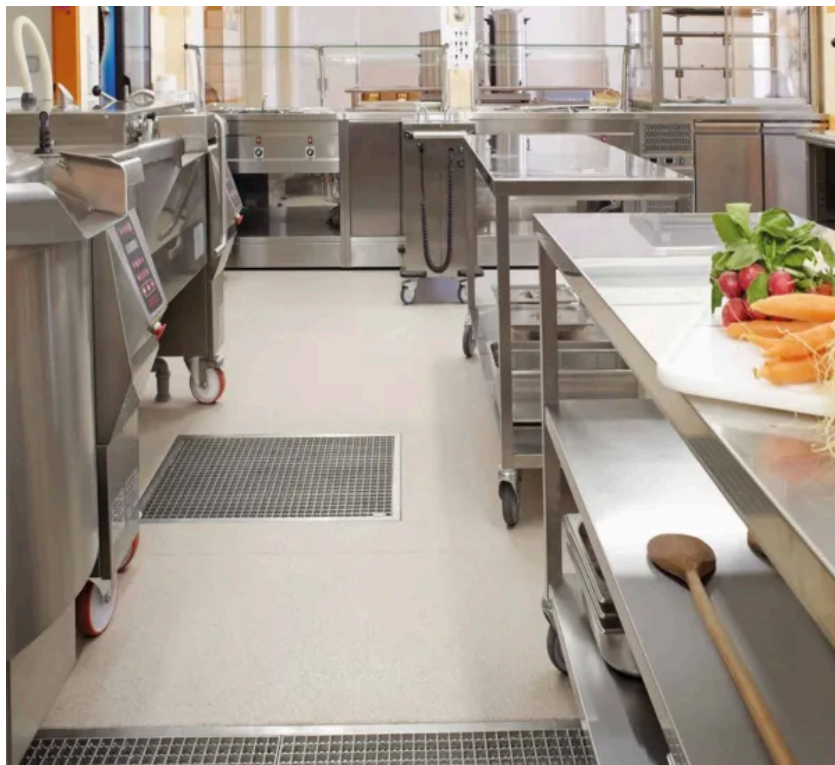
Großküche | © ACO Haustechnik
