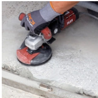
Ecken und Anschlüsse mit einem Tellerschleifer nacharbeiten
