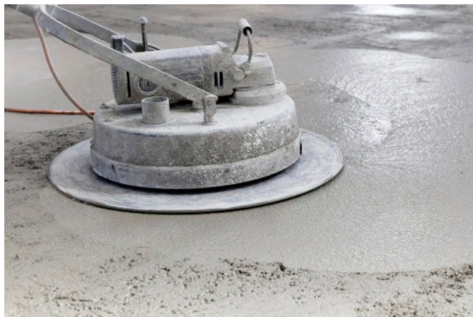
Einbau PCI Novoment Z1
