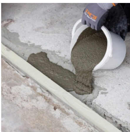
Einfahrtsschiene mit fließfähigem Mörtel hintergießen
