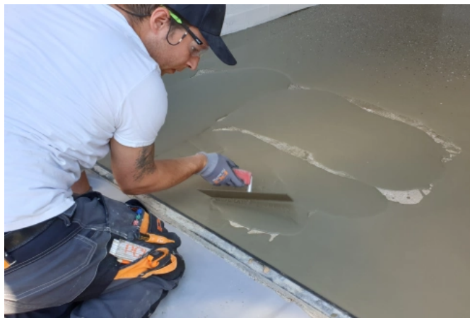
Die mineralische Beschichtung PCI Zemtec Outdoor ist leicht aufzubringen und lässt sich einfach an Kanten anarbeiten
