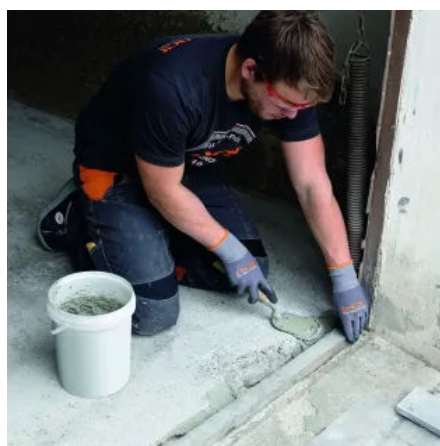
Alternativ Löcher und Ausbrüche mit Mörtel ausspachteln
