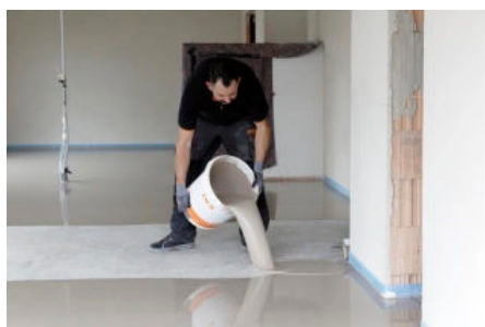
Entspanntes Arbeiten: Anrühren – Ausgießen – Läuft!
