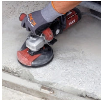
Ecken und Anschlüsse mit einem Tellerschleifer nacharbeiten
