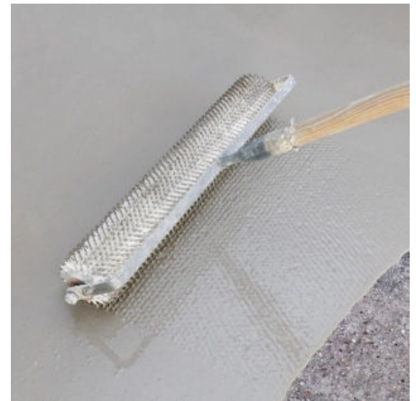
Entlüften mit einer Stachelwalze
