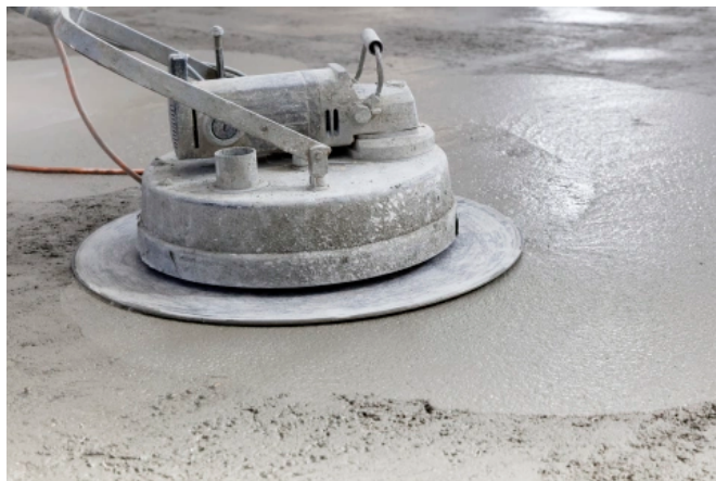
Einbau PCI Novoment Z1
