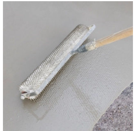
Entlüften mit einer Stachelwalze
