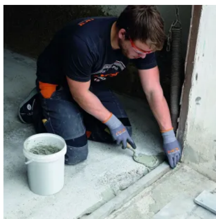
Alternativ Löcher und Ausbrüche mit Mörtel ausspachteln
