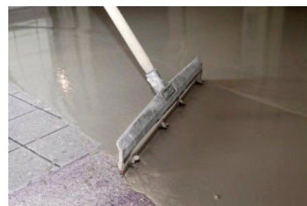
Mit einem Stift- oder Kufenraker lassen sich die Spachtelmassen der PCI Periplan-Familie angenehm im Stehen verarbeiten
