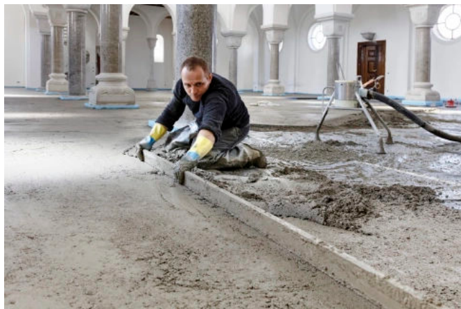
Einbau PCI Novoment Z1
