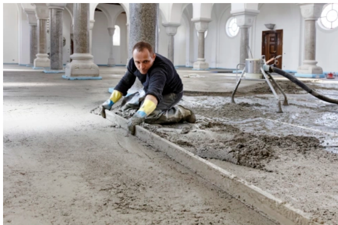
Einbau PCI Novoment Z1
