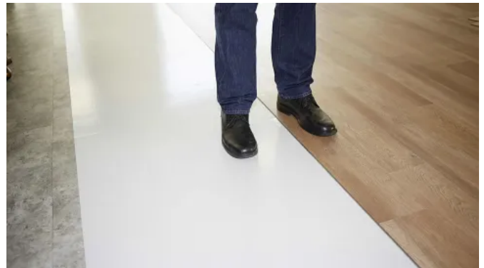
Weil die alten Beläge vorher nicht entfernt werden mussten und der neue Belag direkt darauf verlegt werden konnte, entstand weder Lärm noch Staub oder Schmutz. (© STEPHAN REDEKER)
