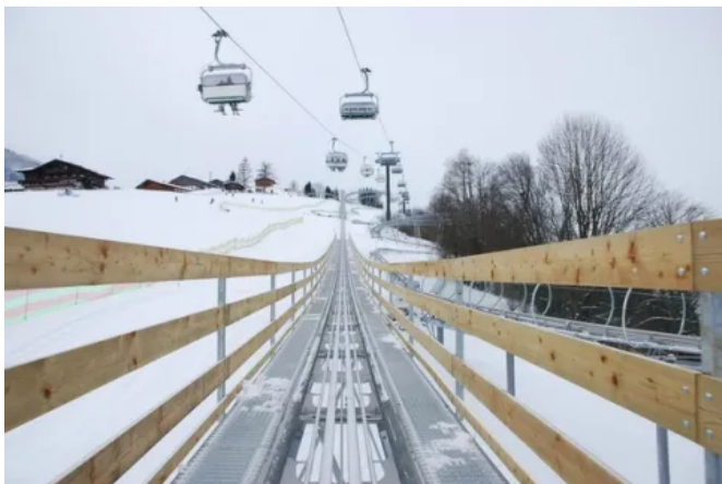
Spezielle Anwendung, Wartungsstege
