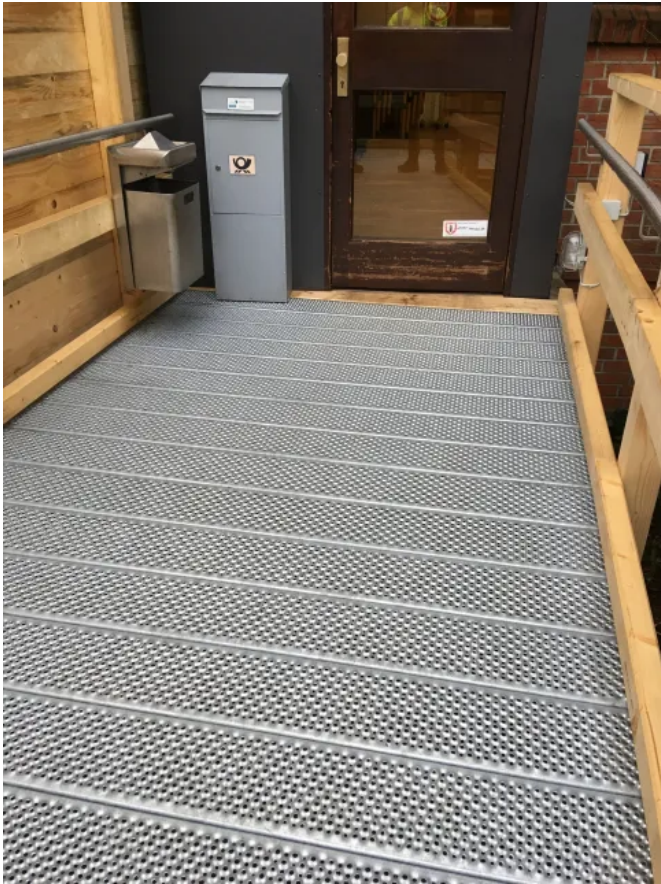
Rampe Seniorenzentrum Wedel
