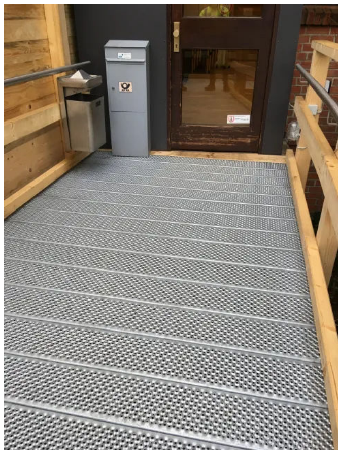
Rampe Seniorenzentrum Wedel
