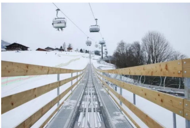
Spezielle Anwendung, Wartungsstege
