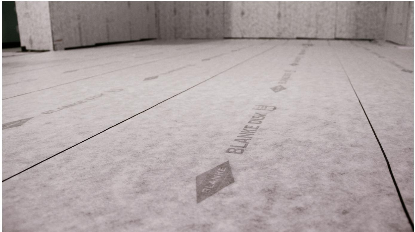
BLANKE DISK ist ein selbstklebendes Abdichtungs-System aus verdichtetem Polyolefinschaum, das zum Verkleben am Untergrund ohne zusätzlichen Fliesenkleber auskommt. Die vollflächige Verklebung mit flächenbündigen, miteinander „verschmelzenden“ Überlappungen ist 100% wasserdicht. Die Verbundabdichtung ist sofort auf Boden und Wand zu verkleben. Anschließend können auch großformatige Fliesen ohne Wartezeit problemlos verlegt werden.
