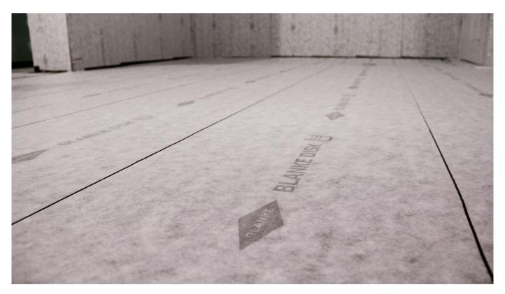
BLANKE DISK ist ein selbstklebendes Abdichtungs-System aus verdichtetem Polyolefinschaum, das zum Verkleben am Untergrund ohne zusätzlichen Fliesenkleber auskommt. Die vollflächige Verklebung mit flächenbündigen, miteinander "verschmelzenden" Überlappungen ist 100% wasserdicht. Die Verbundabdichtung ist sofort auf Boden und Wand zu verkleben. Anschließend können auch großformatige Fliesen ohne Wartezeit problemlos verlegt werden.
