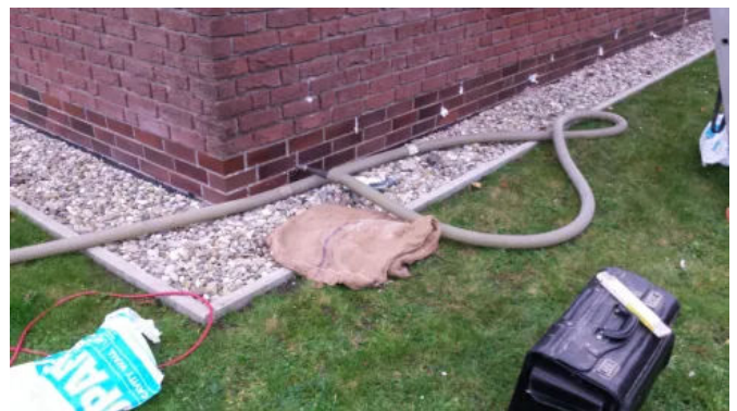
Einblasen von GEOMATERIALS Blähglas als Kerndämmung
