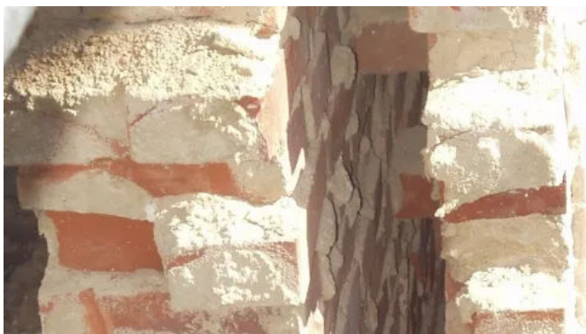
Zu dämmender Hohlraum zwischen Vormauerwerk und Hintermauerwerk
