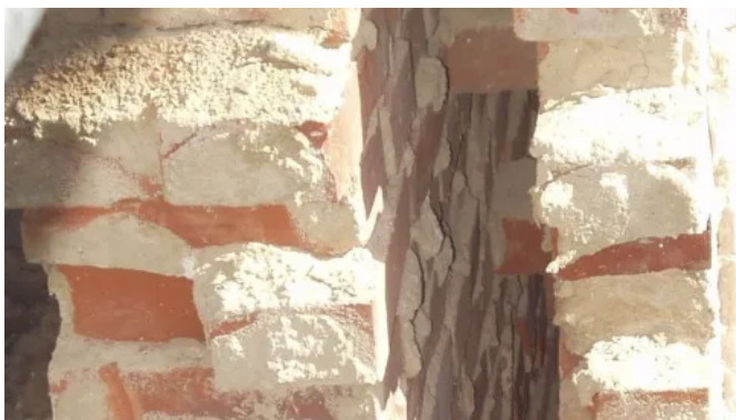
Zu dämmender Hohlraum zwischen Vormauerwerk und Hintermauerwerk
