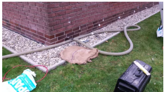
Einblasen von GEOMATERIALS Blähglas als Kerndämmung
