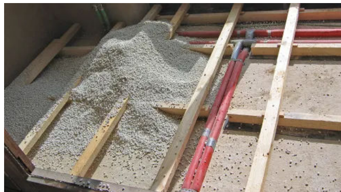
Anwendungsbeispiel: Ausgleichsschüttung zwischen Polsterhölzern
