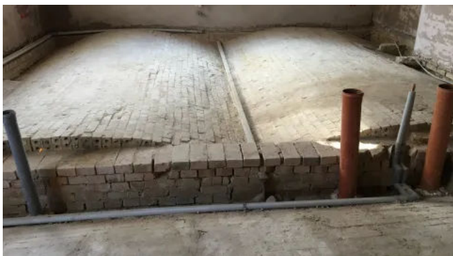
Anwendungsbeispiel: Gewölbedämmung mit GEOMATERIALS Blähglas
