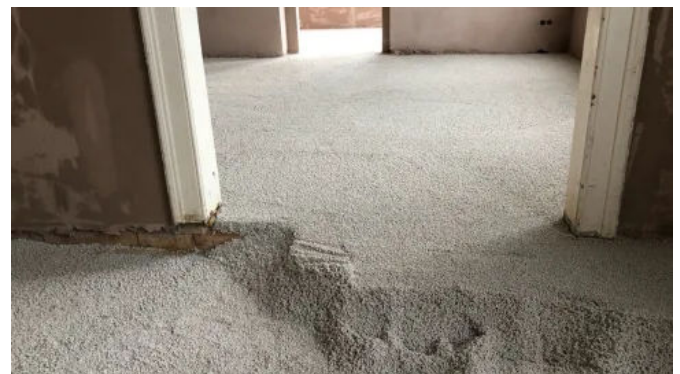
Anwendungsbeispiel: Gewölbedämmung mit GEOMATERIALS Blähglas
