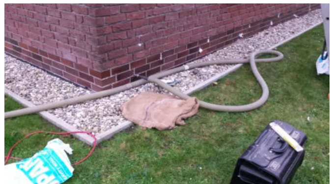
Einblasen von GEOMATERIALS Blähglas als Kerndämmung
