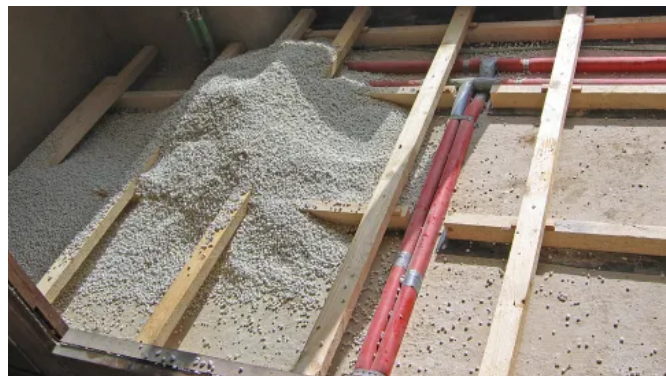
Anwendungsbeispiel: Ausgleichsschüttung zwischen Polsterhölzer
