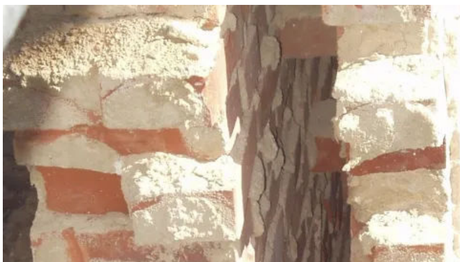
Zu dämmender Hohlraum zwischen Vormauerwerk und Hintermauerwerk
