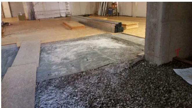
Anwendungsbeispiel: Fußbodensanierung - Kombination GEOMATERIALS Schaumglas & Blähglas
