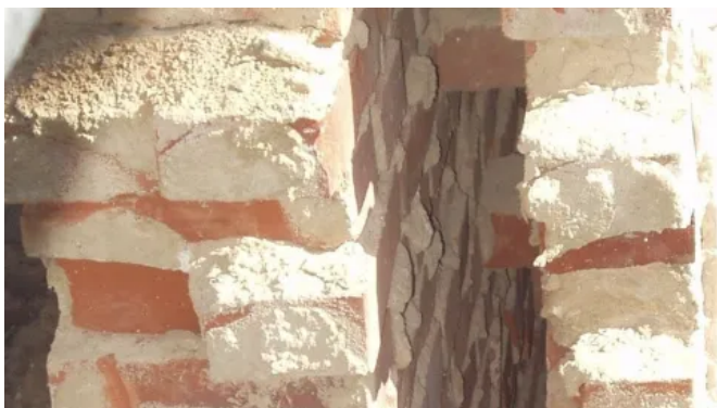
Zu dämmender Hohlraum zwischen Vormauerwerk und Hintermauerwerk
