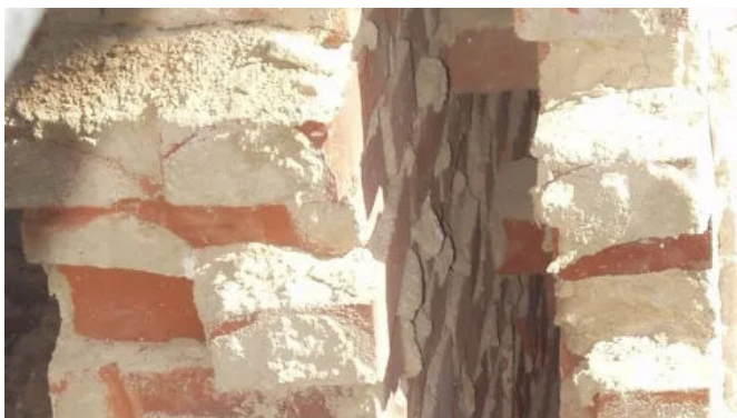
Zu dämmender Hohlraum zwischen Vormauerwerk und Hintermauerwerk
