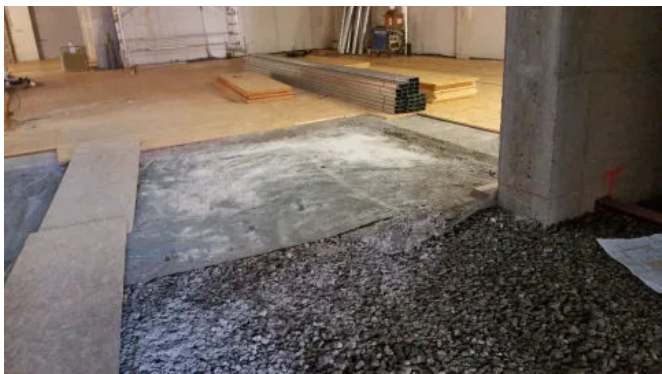
Anwendungsbeispiel: Fußbodensanierung - Kombination GEOMATERIALS Schaumglas & Blähglas
