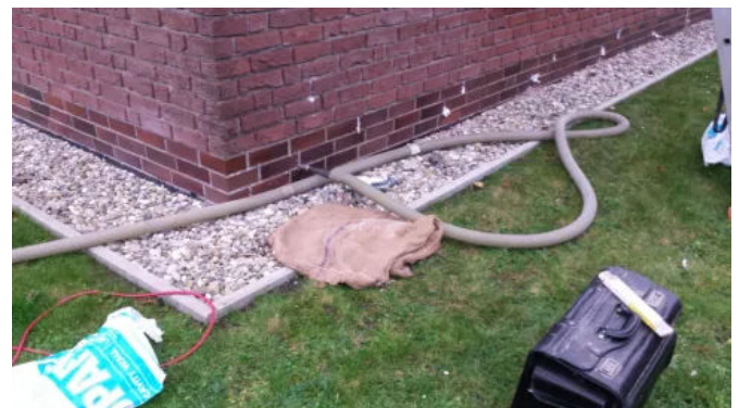
Einblasen von GEOMATERIALS Blähglas als Kerndämmung
