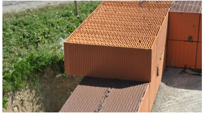
Der Deckenmörtel kann nach Freifegen der Ziegel wie gewohnt aufgetragen werden
