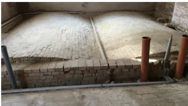
Anwendungsbeispiel: Gewölbedämmung mit GEOMATERIALS Blähglas
