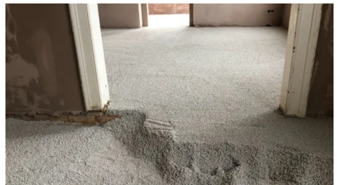
Anwendungsbeispiel: Gewölbedämmung mit GEOMATERIALS Blähglas
