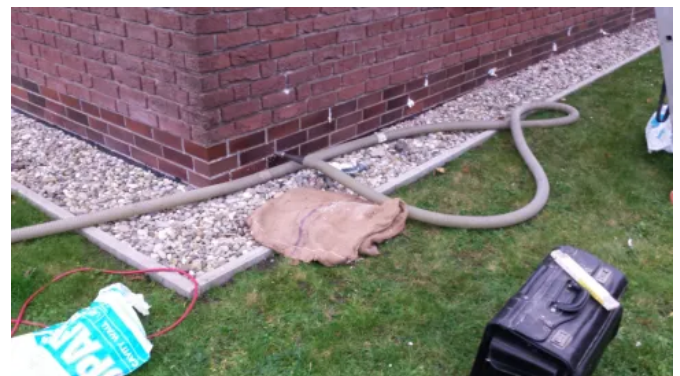
Einblasen von GEOMATERIALS Blähglas als Kerndämmung
