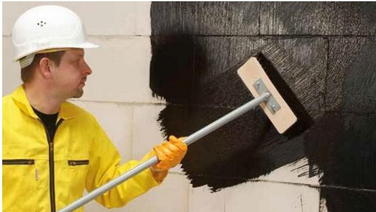
Bitumengrundierung, -voranstrich, -schutzanstrich, -dickanstrich, -spachtel und Kaltselfstklebebahnen
